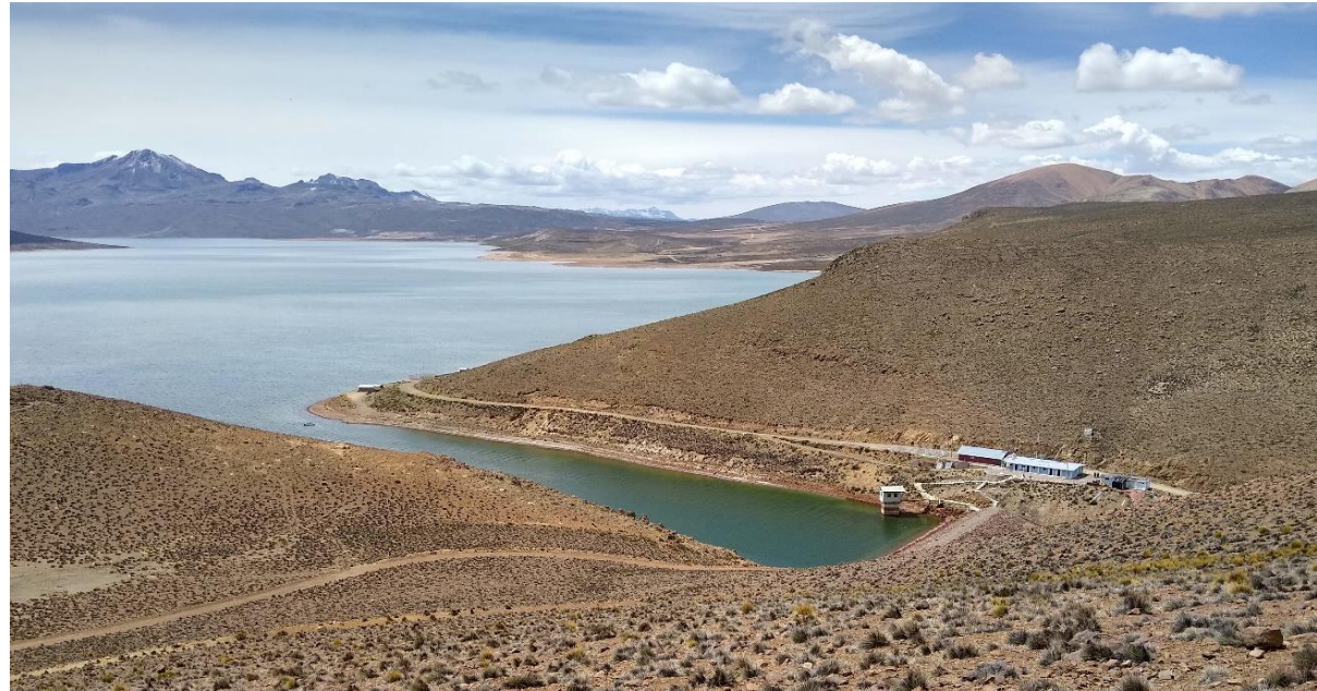
“Presa Pasto Grande”
