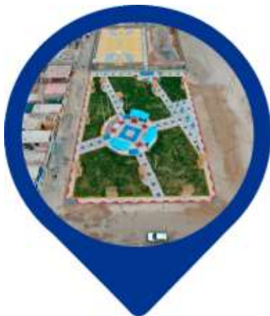
INSTALACION DE INFRAESTRUCTURA DEPORTIVA EN EL PARQUE N°1 EN EL A.A.H.H. JUAN PABLO II, PROMUVI X EN LA PAMPA INALAMBRICA. S/. 902,878.82
