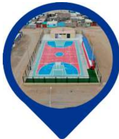
CREACIÓN DE LOSA MULTIUSOS EN LA MZA. H DEL A.H VILLA LA LIBERTAD. S/. 748,424.72
