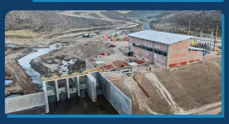
La infraestructura consiste en la captación y almacenamiento del aqua de los ríos Chilota y Vizcachas a través de una bocatoma, para que luego esta pueda ingresar a un sistema de bombeo que conducirá el recurso hídrico hasta el canal Pasto Grande, y que será derivado hasta Lomas de llo para lograr la irrigación de alrededor de 1 650 hectáreas de cultivo.
