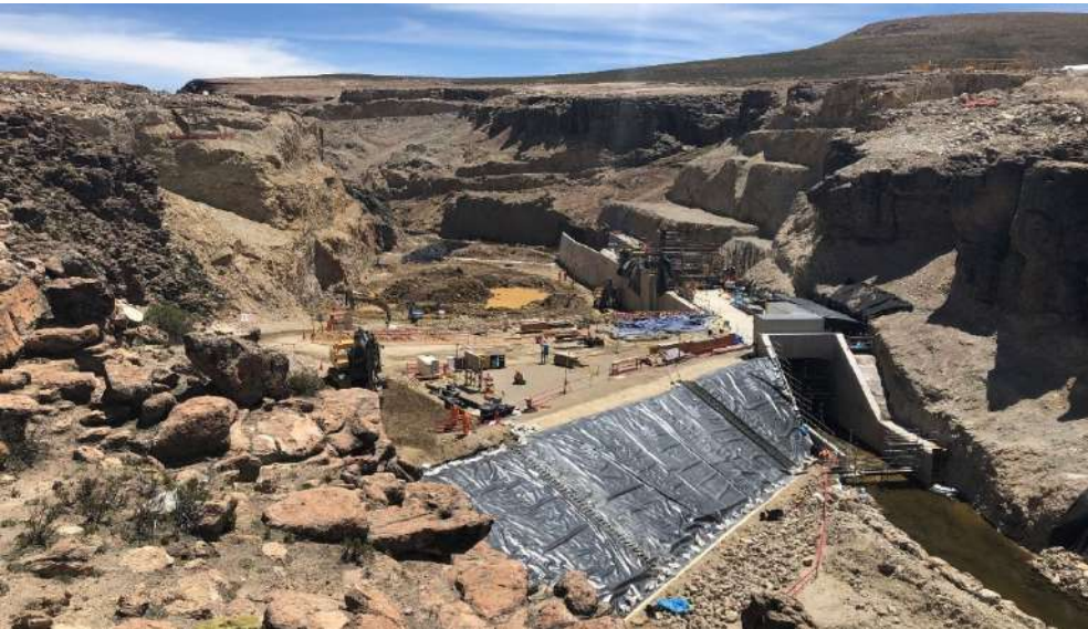
Avance de la Construcción de la Presa Vizcachas
