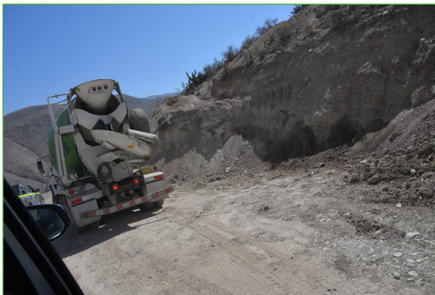
Figura 6.675. Trabajos de maquinaria pesada cercanas al punto Ca-Calientes
