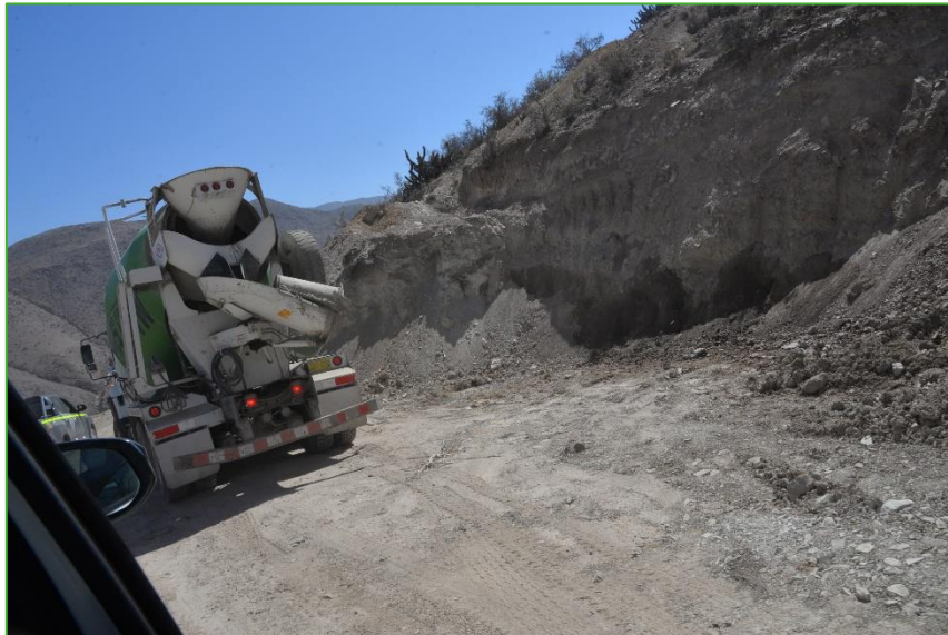
Figura 6.4. Trabajos de maquinaria pesada cercanas al punto Ca-Calientes
