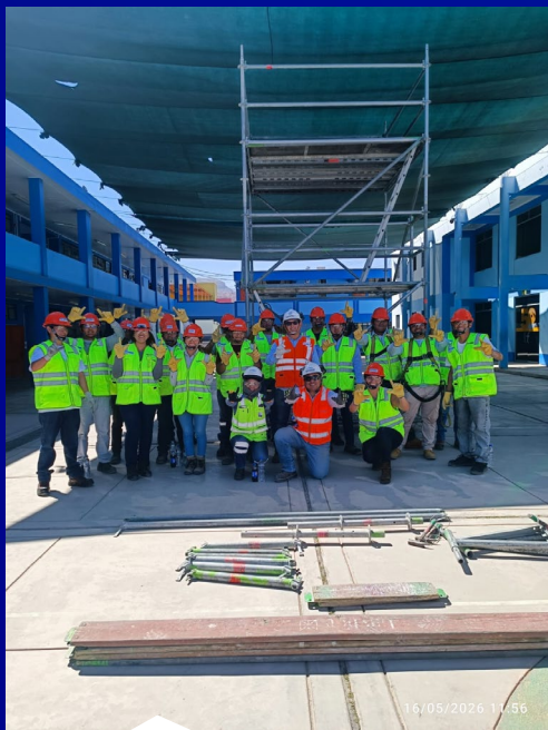
Montaje de andamios - PROSERING
